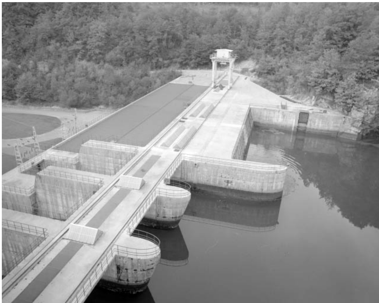
Centrale hydroélectrique du Saut-Mortier, Cernon : évacuateur de crue et toiture de l'usine.
