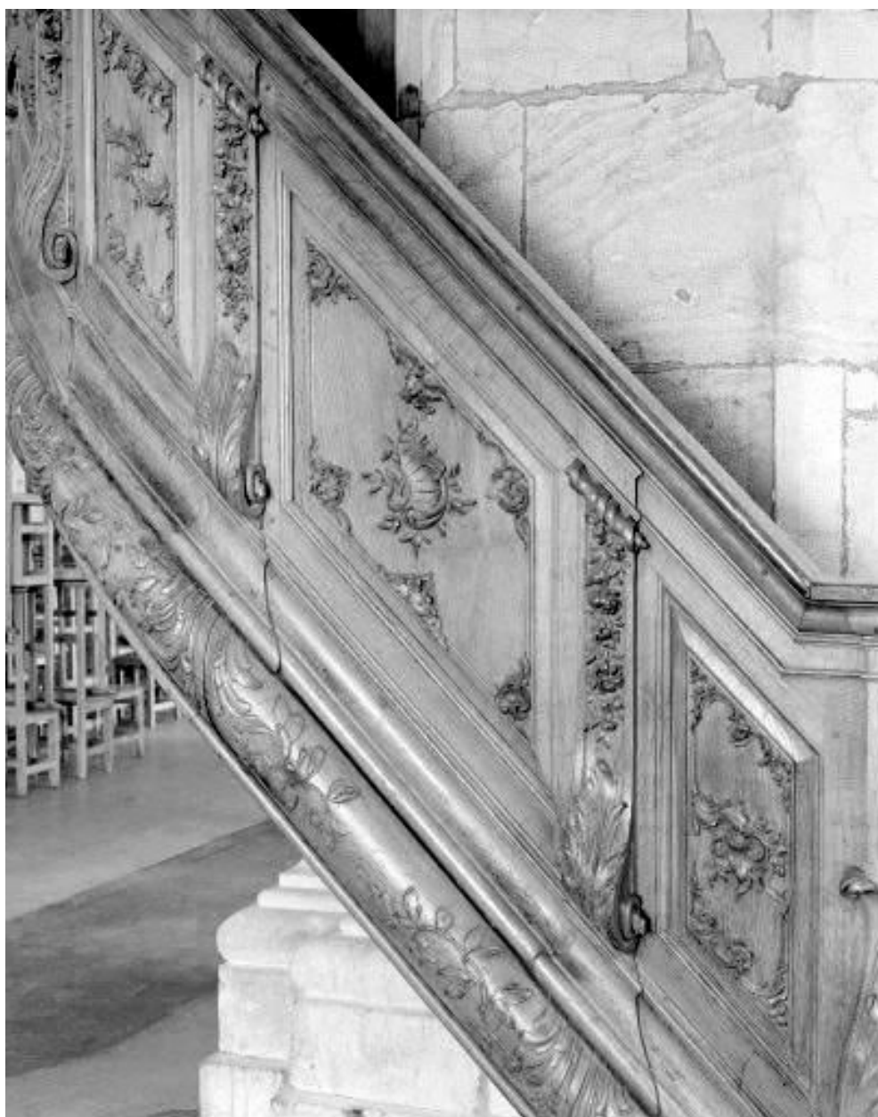
Détail : panneau de la rampe.
