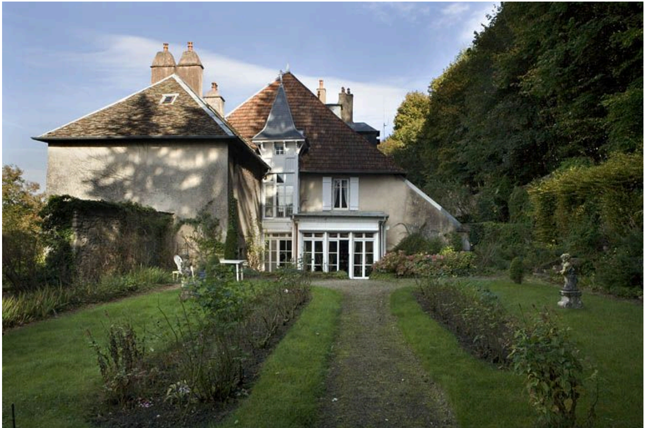
Façade latérale droite : vue éloignée depuis le fond du jardin.
