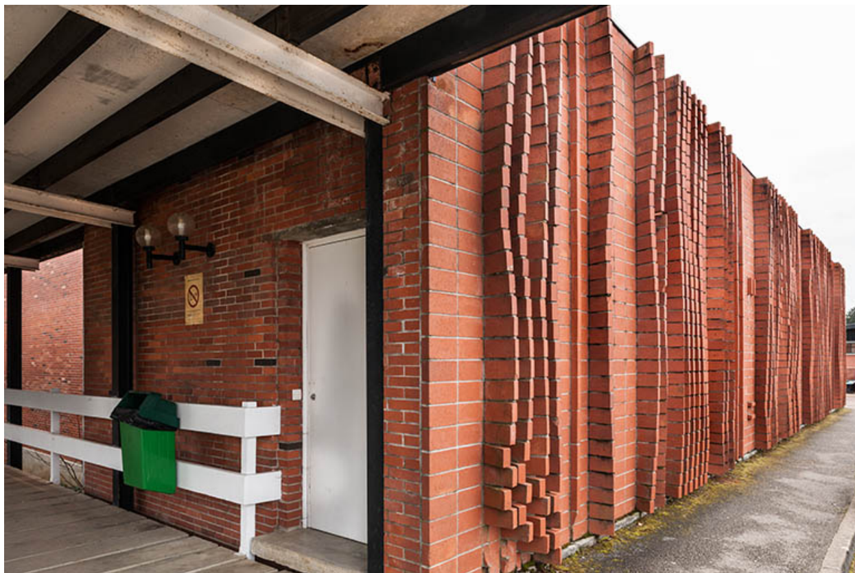
Mur sud vu de profil.
