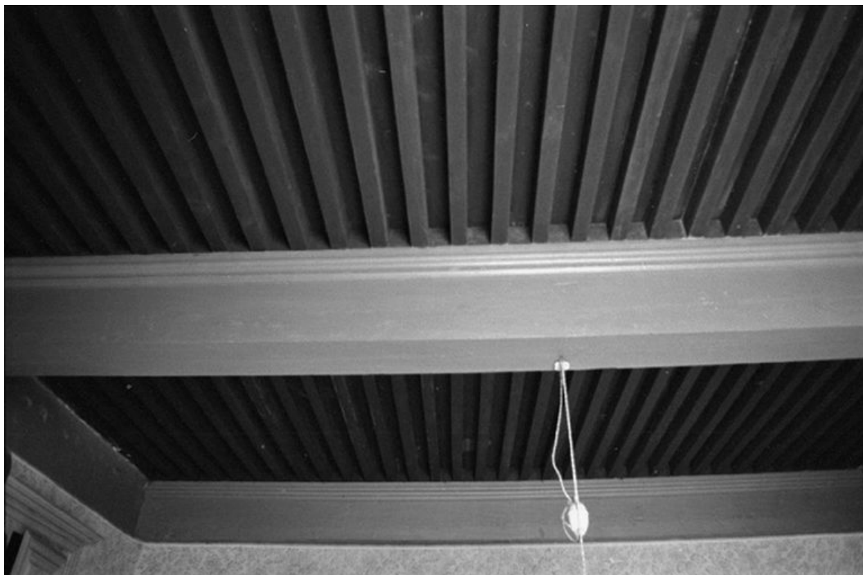
Intérieur : plafond de la cuisine.
