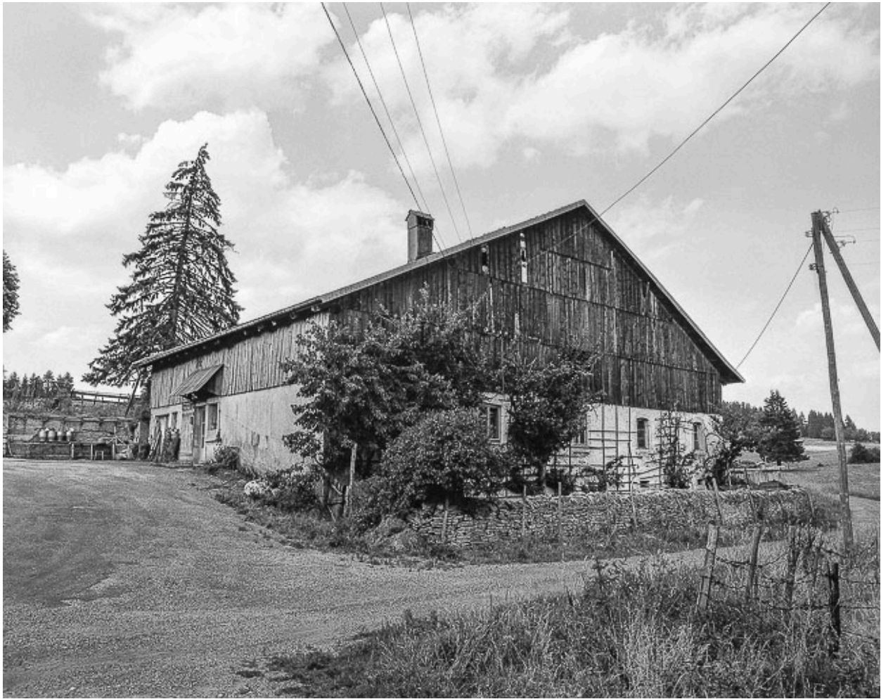
ferme située au lieu-dit Grand Cerneux : façade antérieure et latérale gauche.
