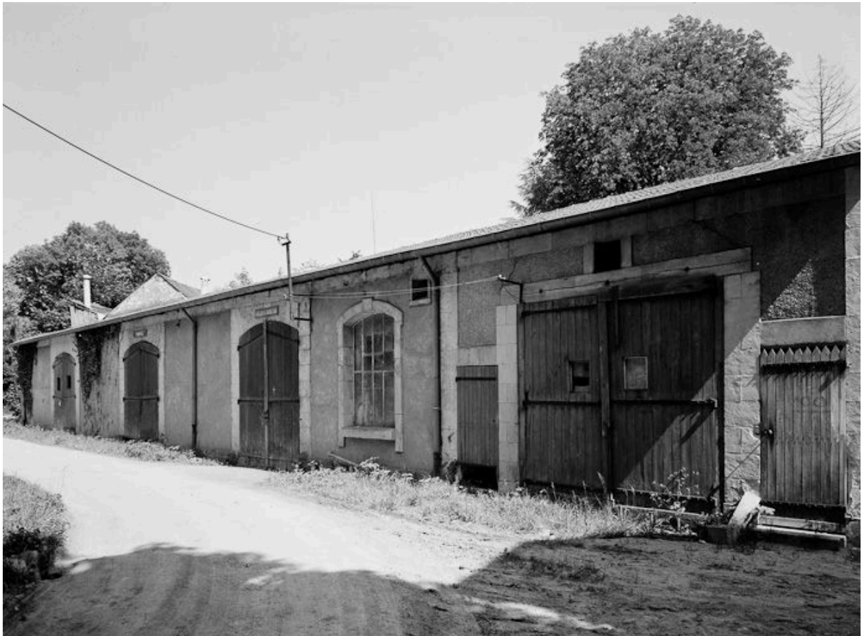
Vue du bâtiment avant sa transformation en dépendance du centre d'art contemporain.
