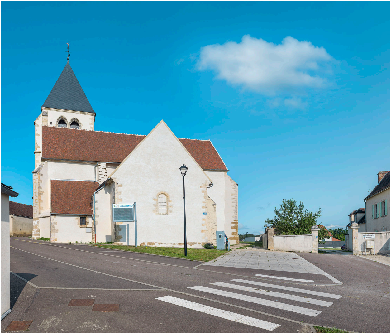
Vue d'ensemble depuis le chevet.
