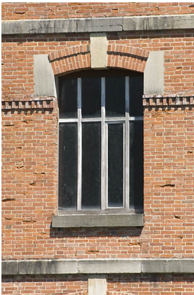
Détail d'une fenêtre du bâtiment d'eau.
