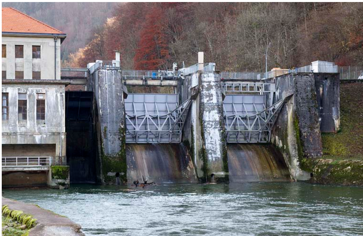
Le barrage vu de l'aval.
