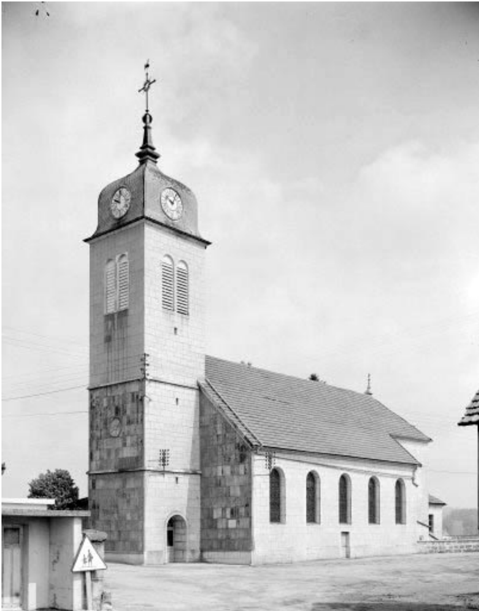
Façade latérale droite.
