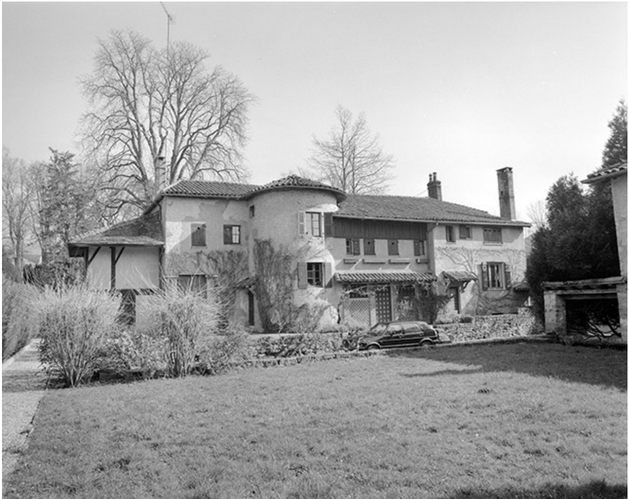
Façade antérieure du logement patronal (O).
