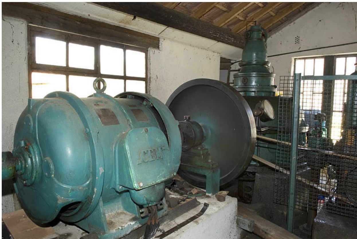
Intérieur de la salle des machines (sud). Alternateur CEM.
