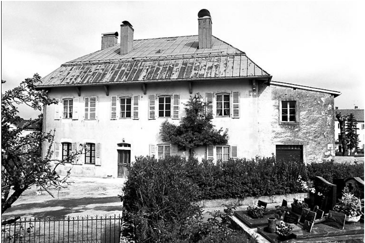
Façade antérieure vue depuis le cimetière.
