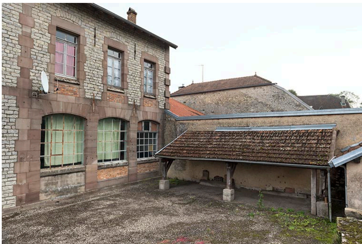
Cour, préau, détail de la façade postérieure.
