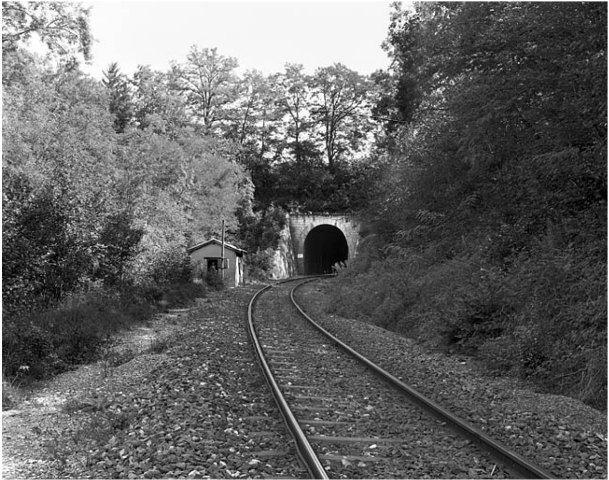
Tunnel d'Arbent 2 : vue d'ensemble de la tête côté Andelot-en-Montagne (ouest).
