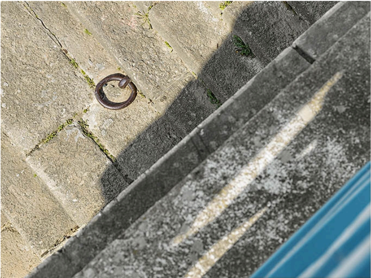
Détail d'un organeau sur les marches du port Villiers.
