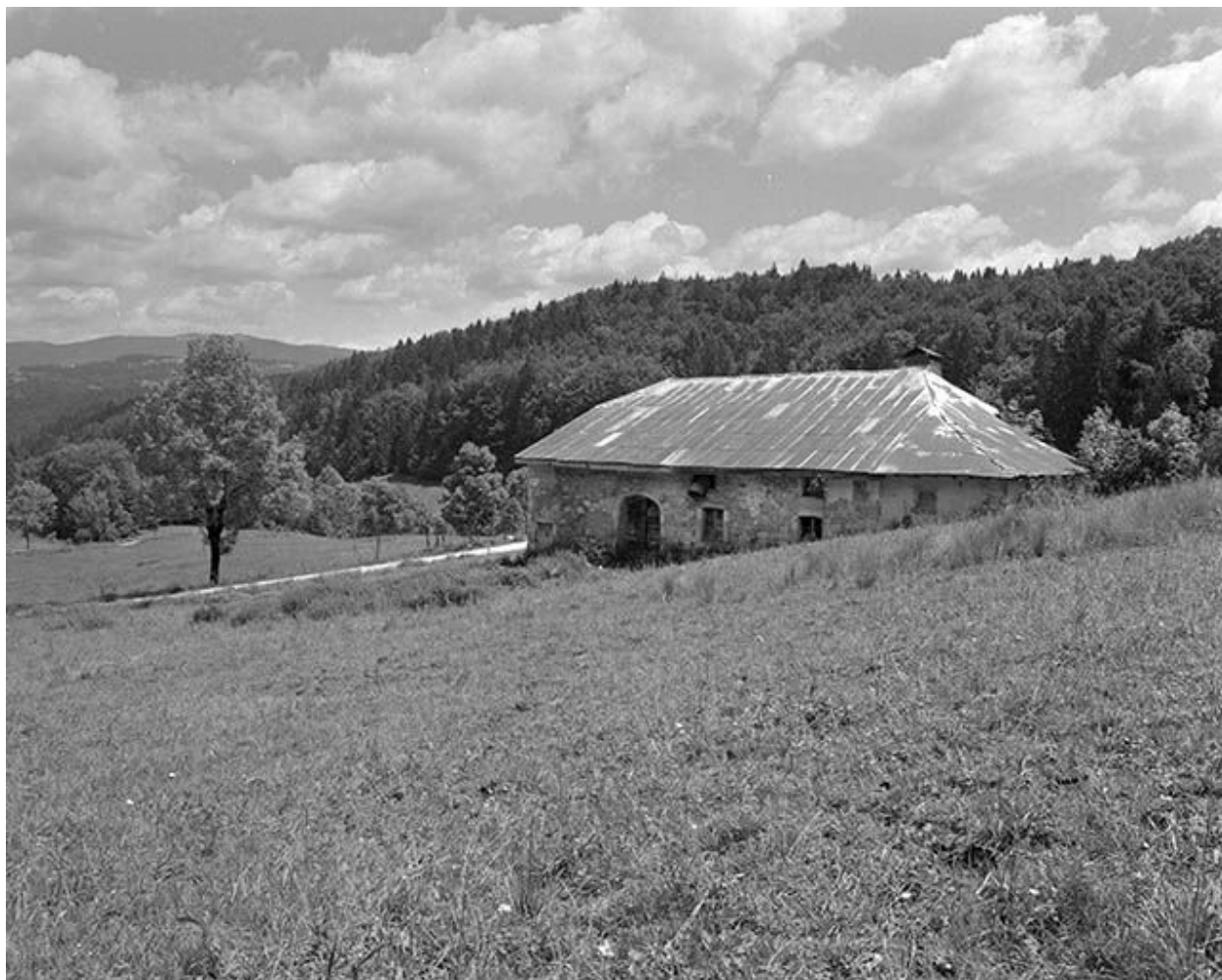
Vue éloignée de la façade postérieure.
