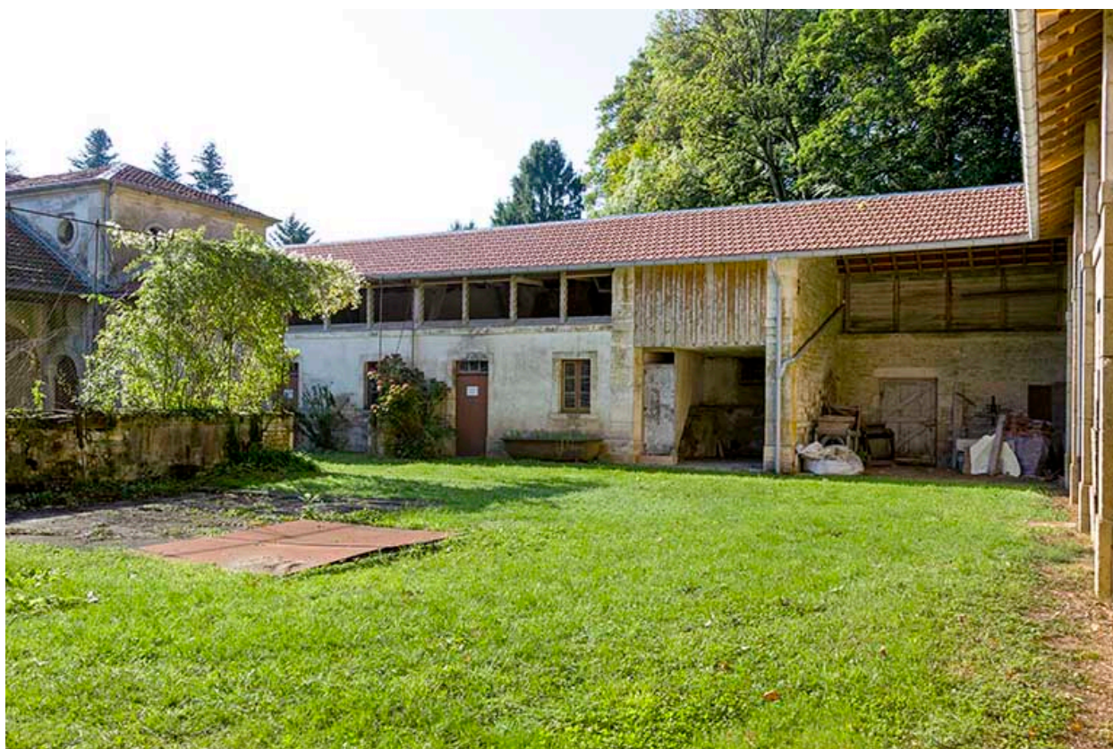
Vue générale de l'aile sud-ouest, côté cour.
