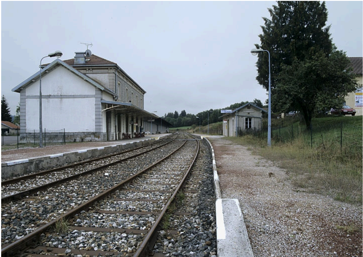
Bâtiment des voyageurs et abri : vue d'ensemble, depuis le nord (côté Andelot-en-Montagne).
