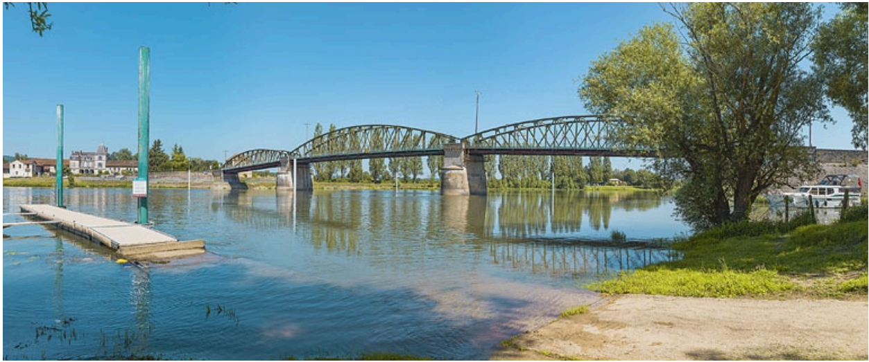
Le pont de Fleurville, vu d'aval, depuis la rive gauche.
