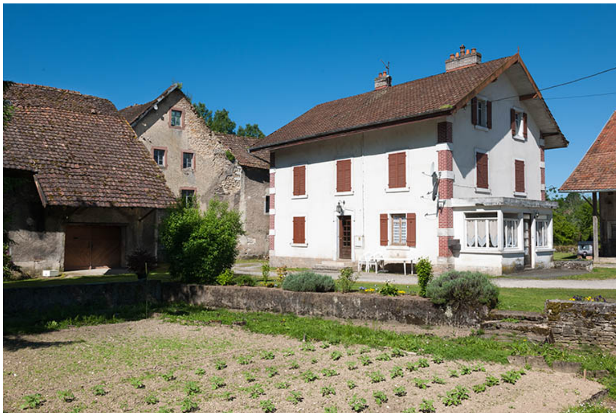
Moulin et logement vus depuis l'est.
