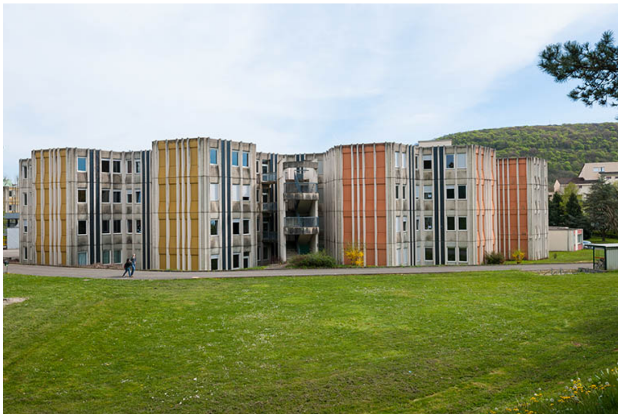
Vue d'ensemble des façades postérieures de l'internat.
