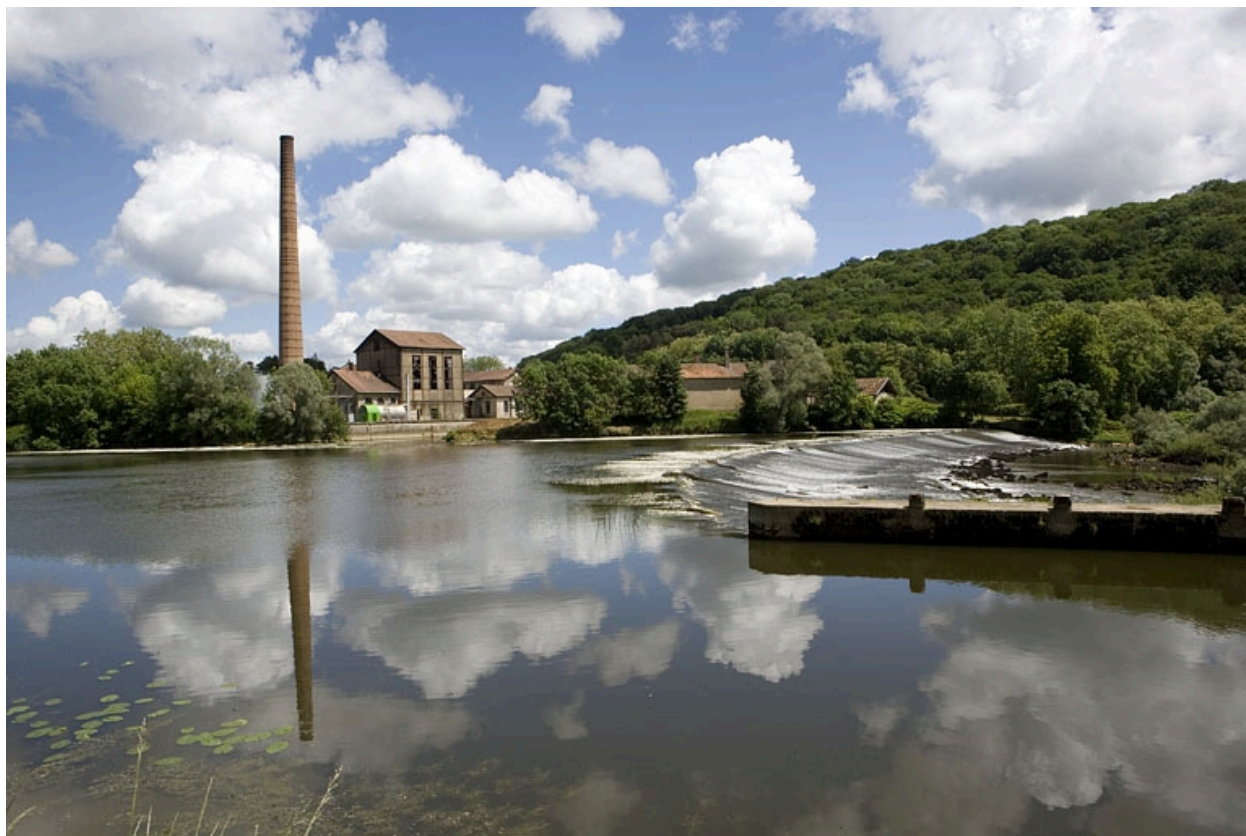
Usine de papeterie Zuber Rieder et Cie, Boussières.
