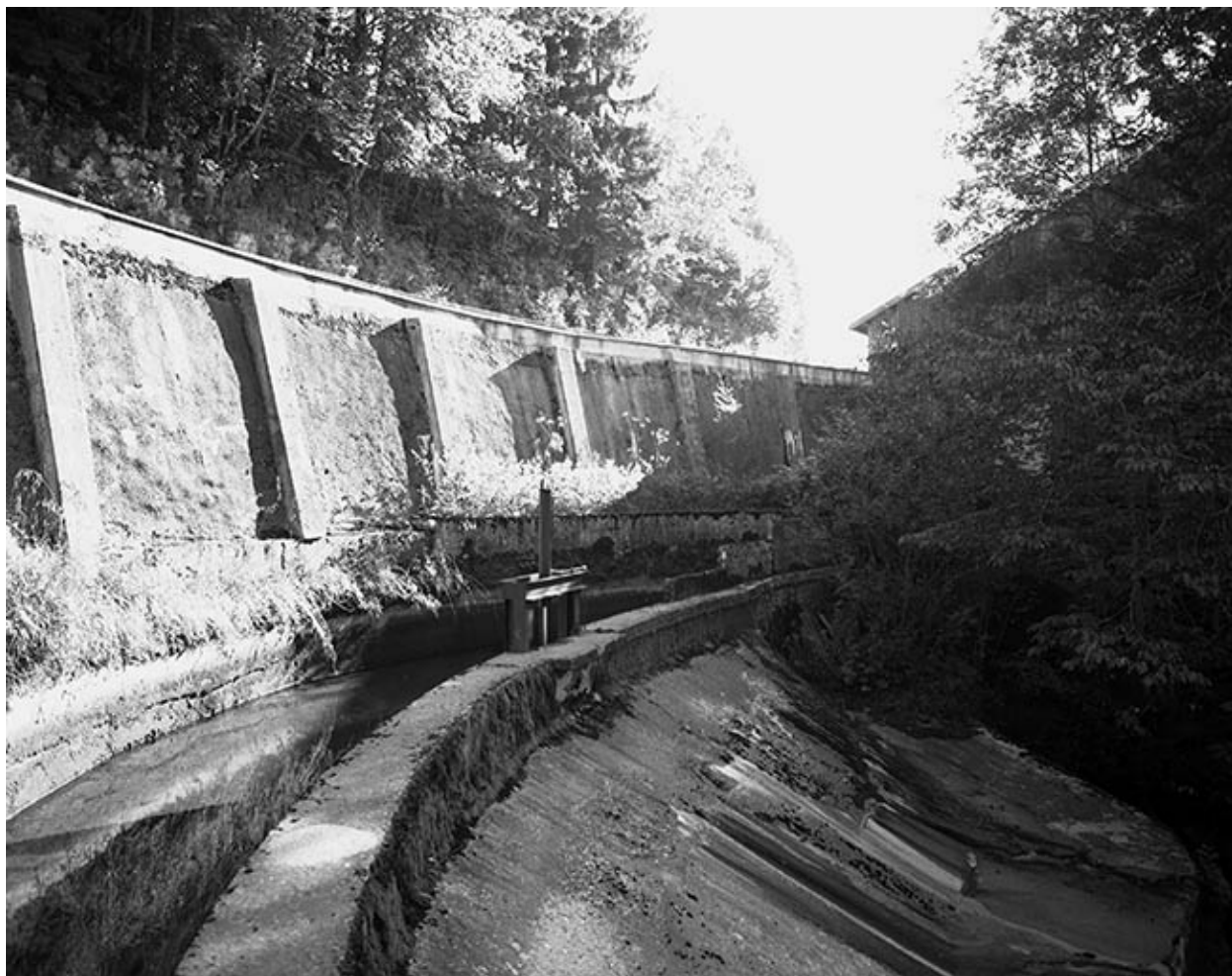
Canal d'amenée et déversoir du barrage.
