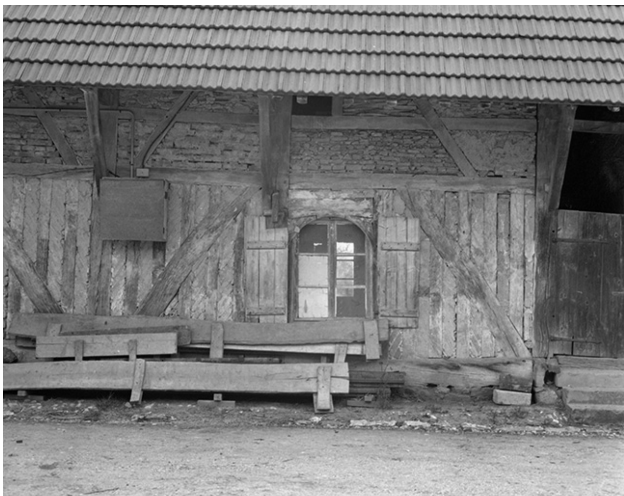
Bâtiment d'habitation : détail de la façade antérieure.
