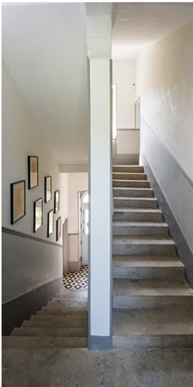
Le premier palier intermédiaire de l'escalier.
