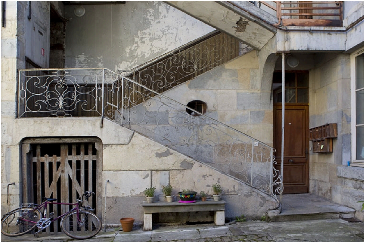
Détail du départ de l'escalier à cage ouverte dans la première cour.
