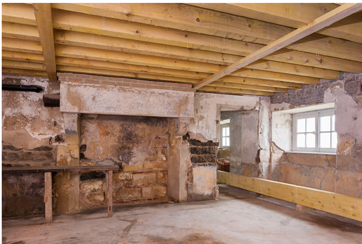
La cuisine du sous-sol et sa cheminée.
