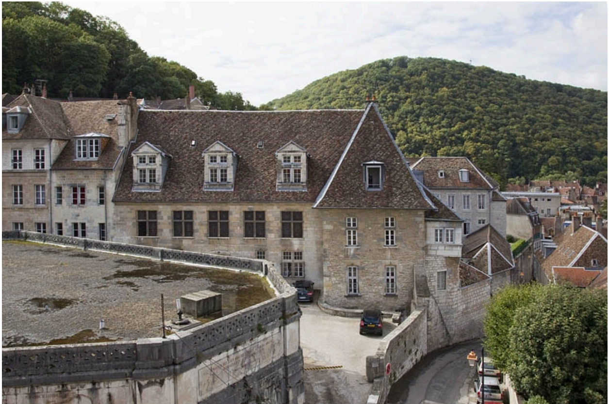
Vue d'ensemble depuis le vieil archevêché.
