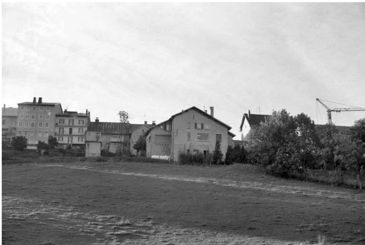
Vue d'ensemble : façade postérieure.
