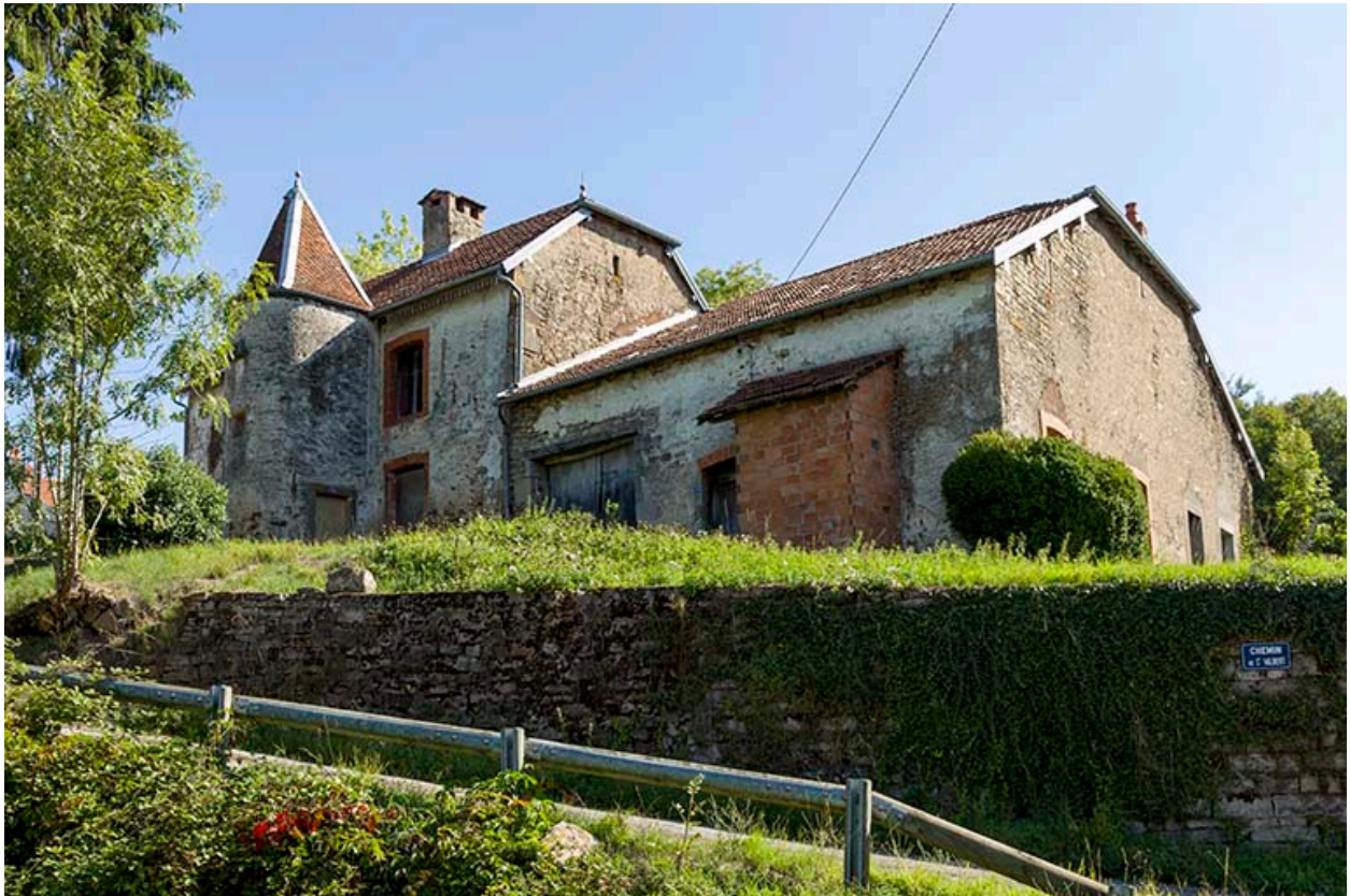
Vue depuis la rue du Moulin.
