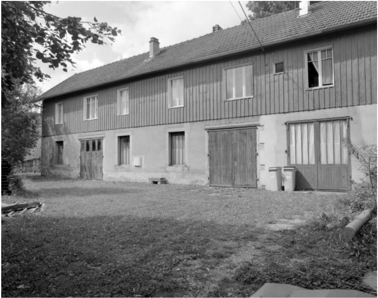
Remise et boutique (pièce d'exposition des voitures).
