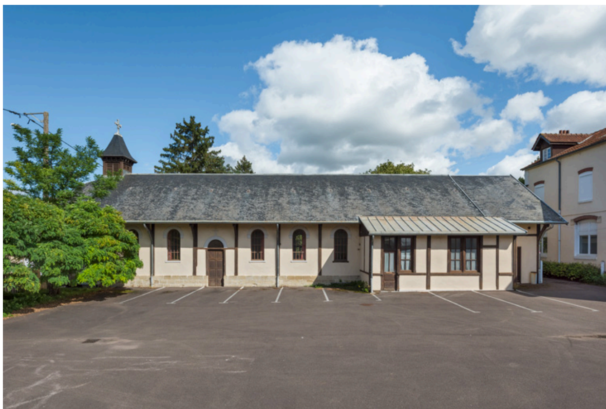
Façade ouest. Vue d'ensemble.
