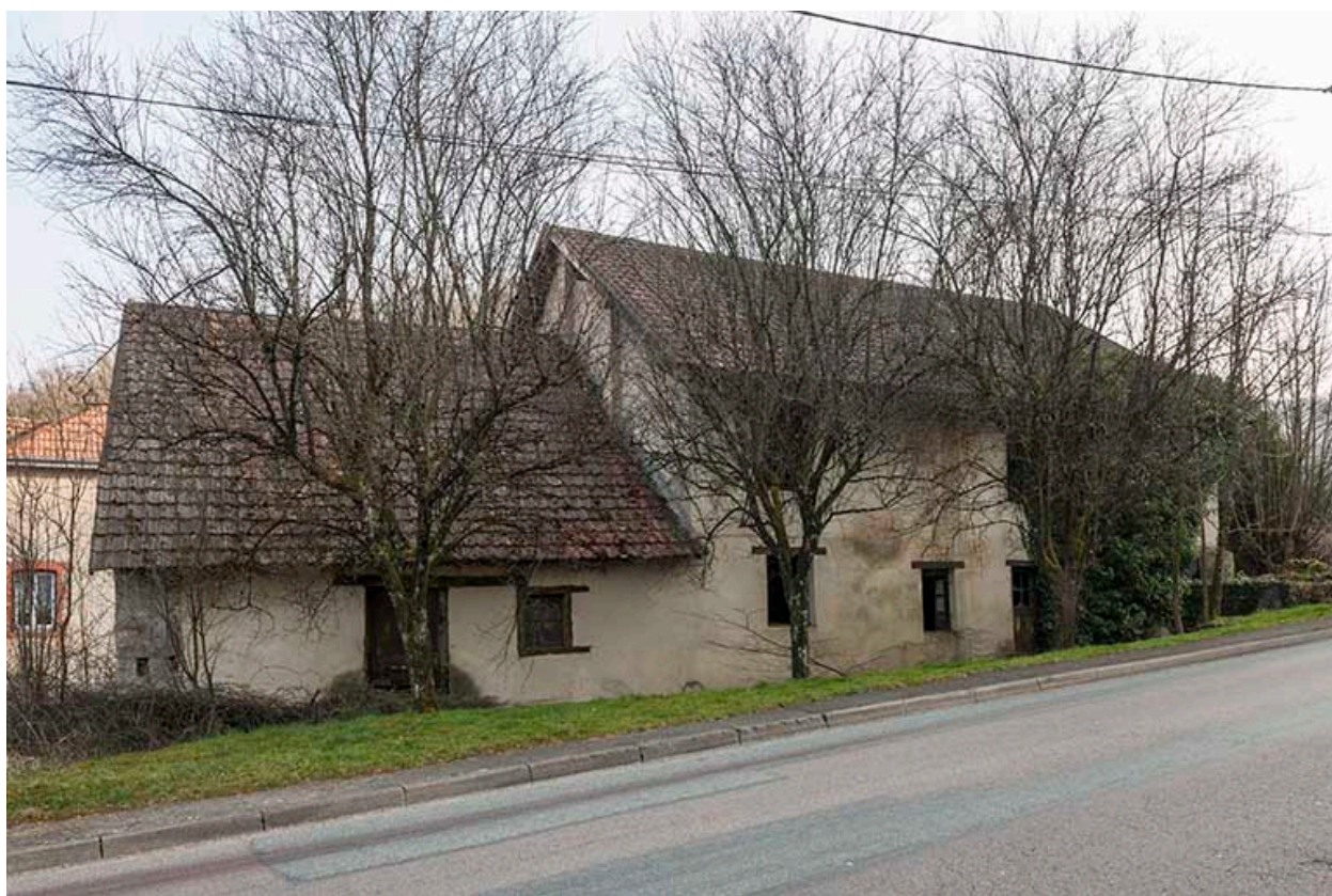
Façade ouest de la minoterie.
