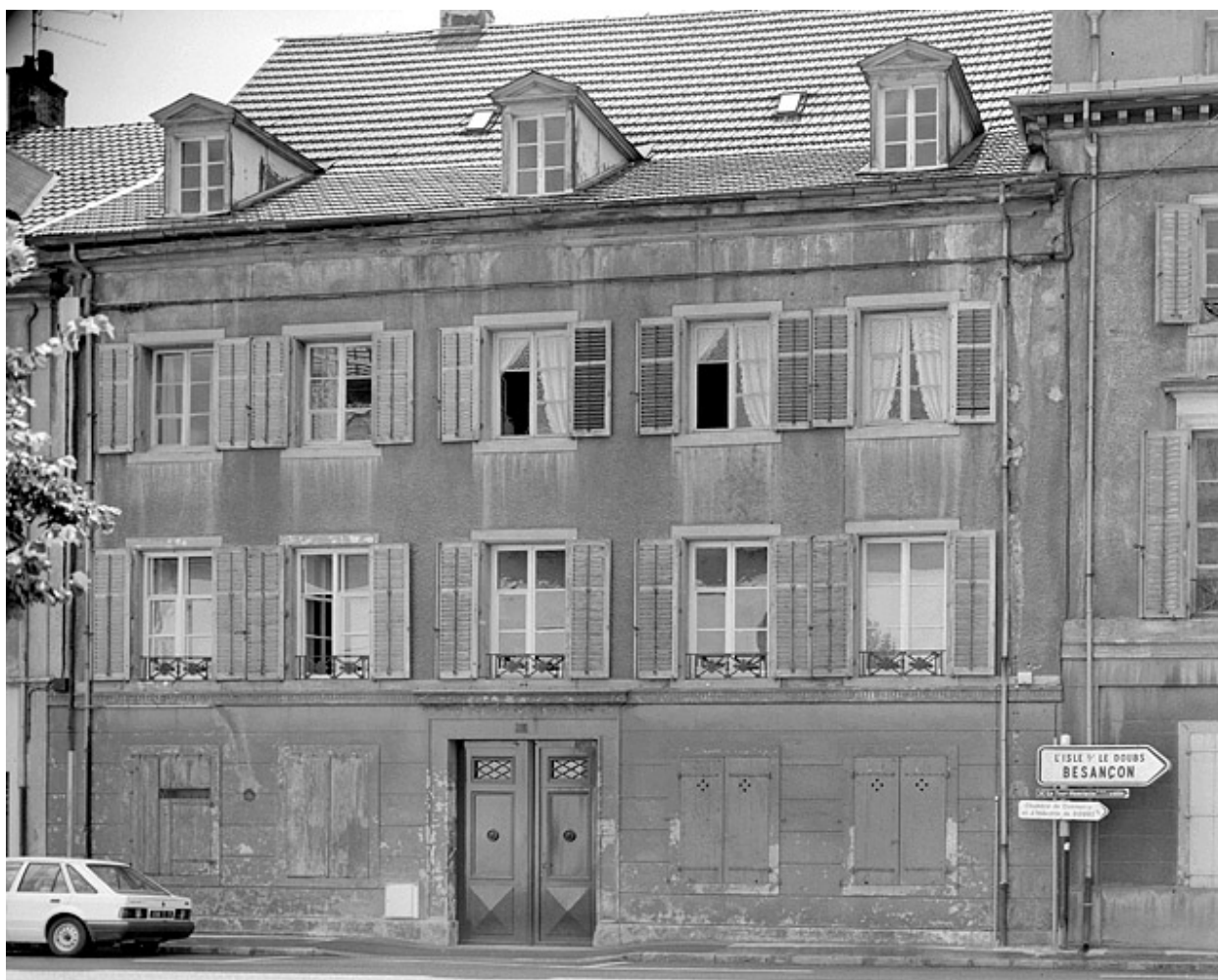
Façade principale sur rue.
