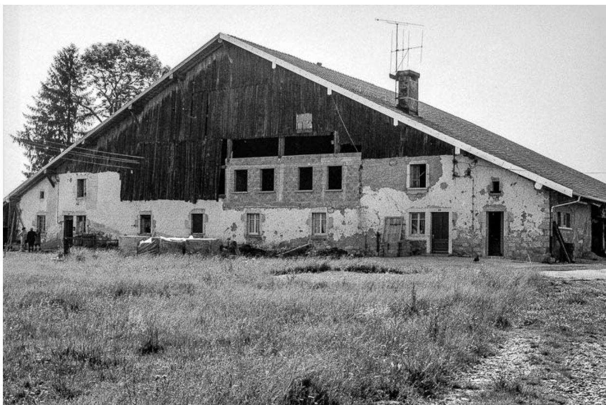
Ferme cadastrée 1938 E 266-267 : façade antérieure.
