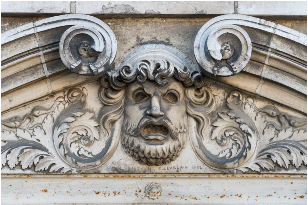
Façade latérale gauche, étage carré : masque de la Tragédie, signature F. Levillain et date 1882.
