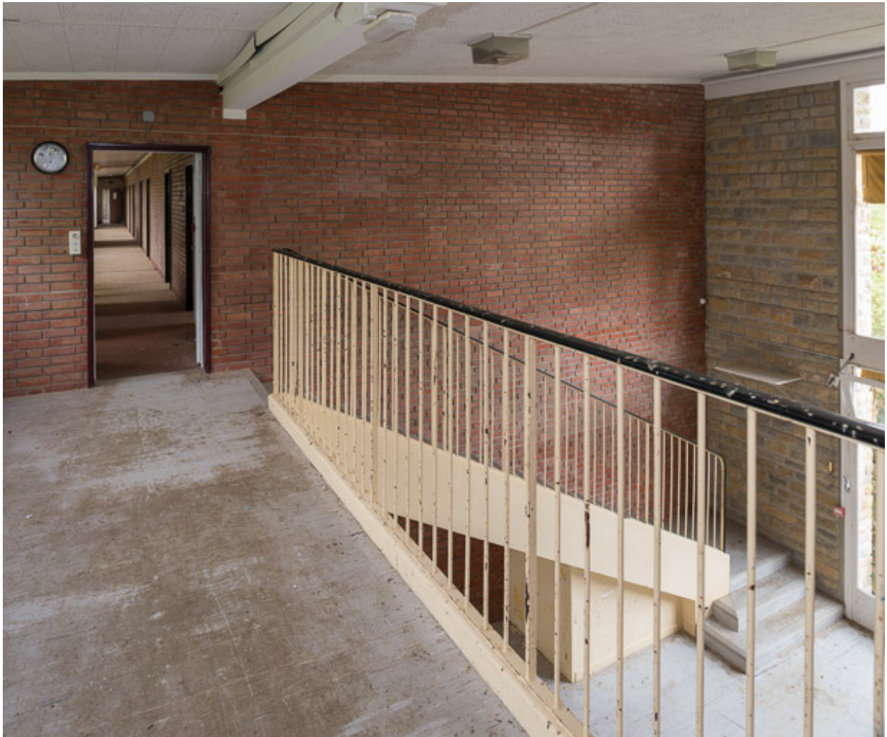
Salle de jeux au centre de l'aile Bellevue, escalier, palier supérieur.
