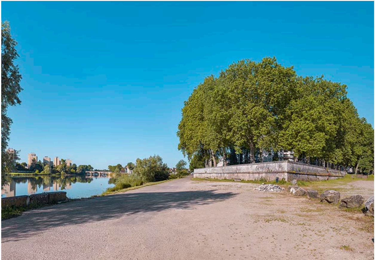
Le bastion, vue depuis l'amont.
