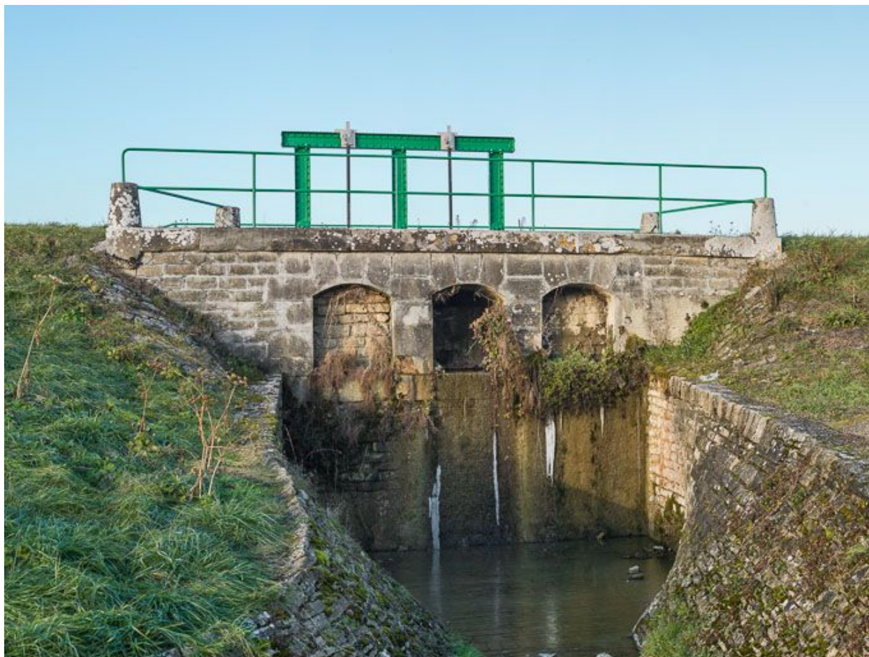
Vue du déversoir.
