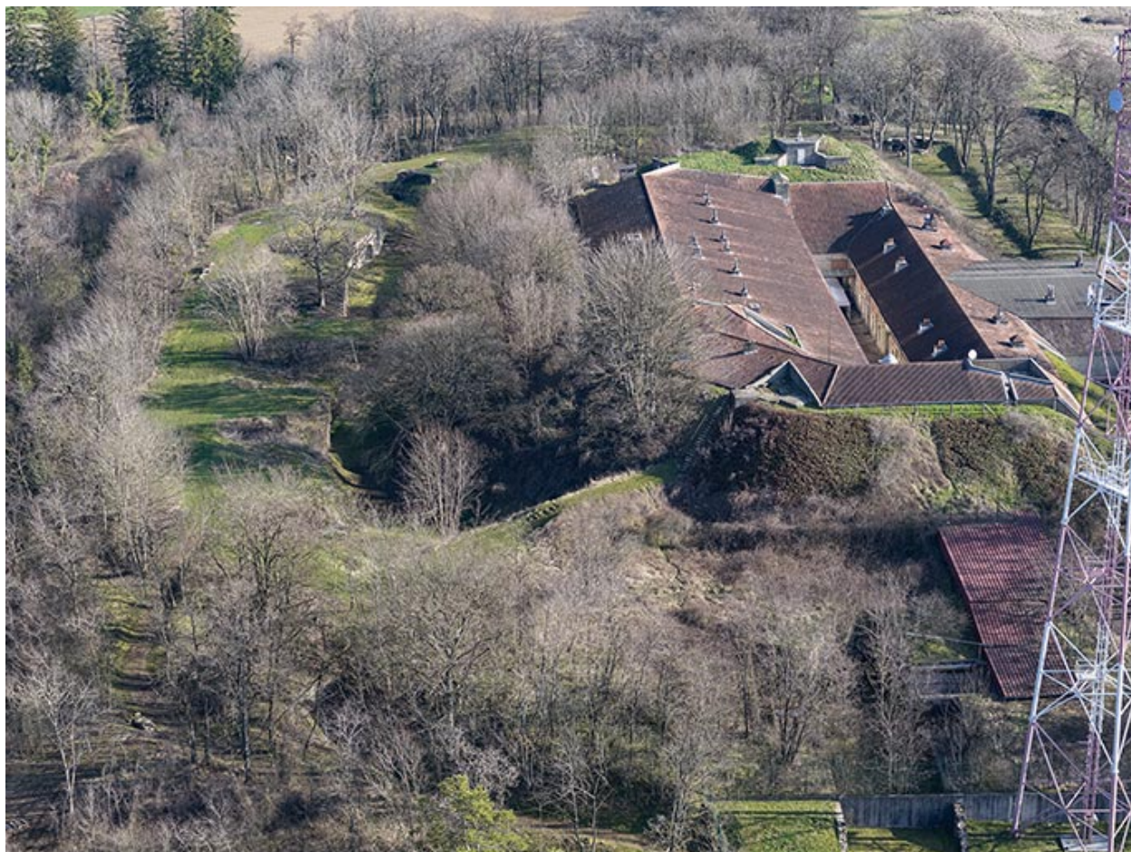
Vue du front d'attaque (à gauche) et de l'espace de casernement (à droite). (vue aérienne).
