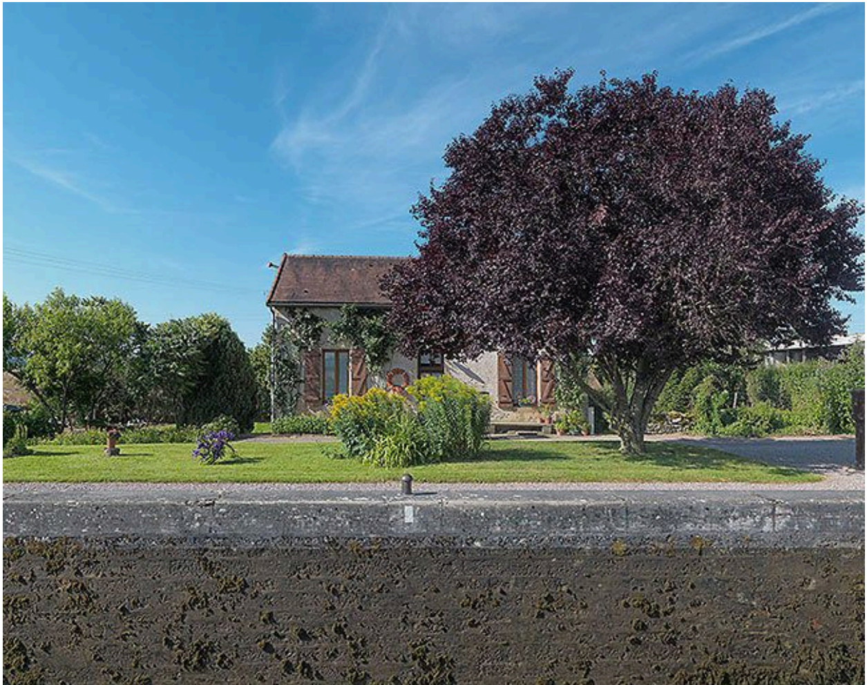
La maison éclusière de face.
