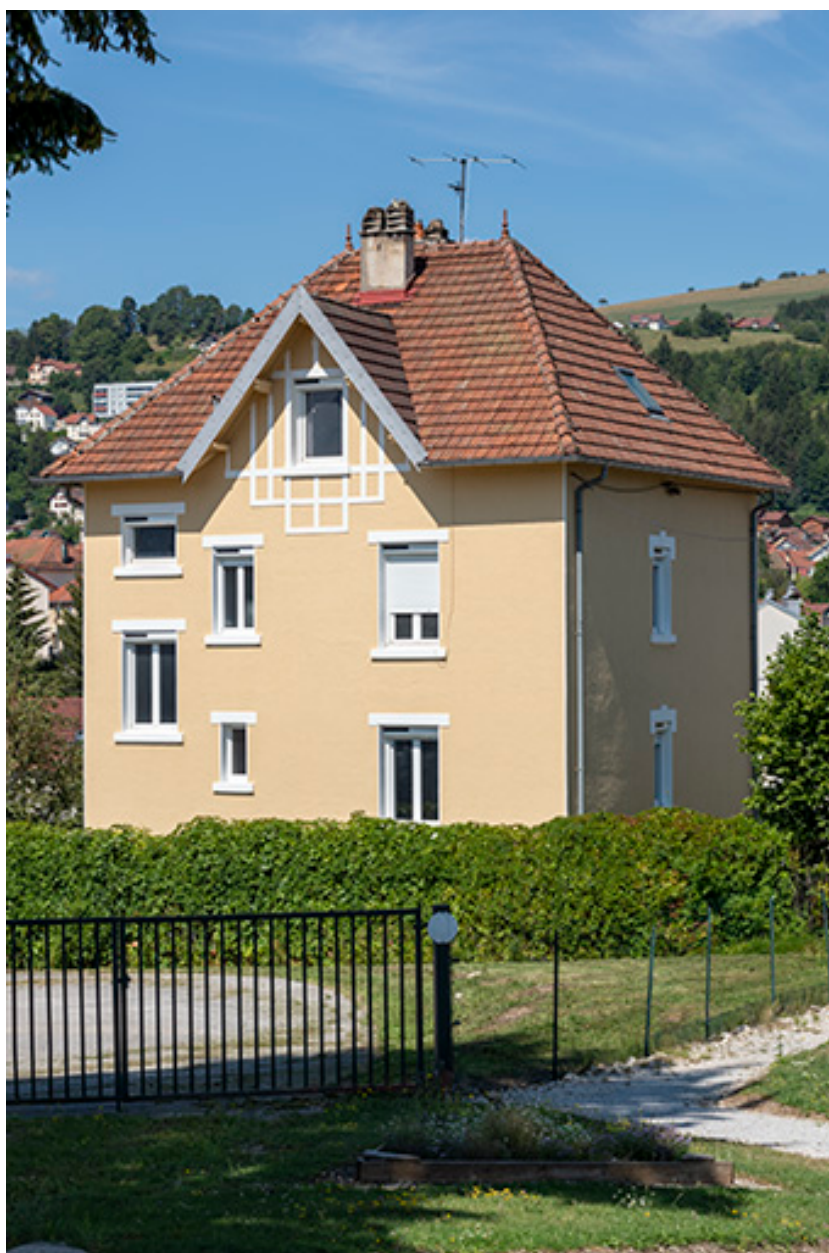
Façades postérieure et latérale gauche.
