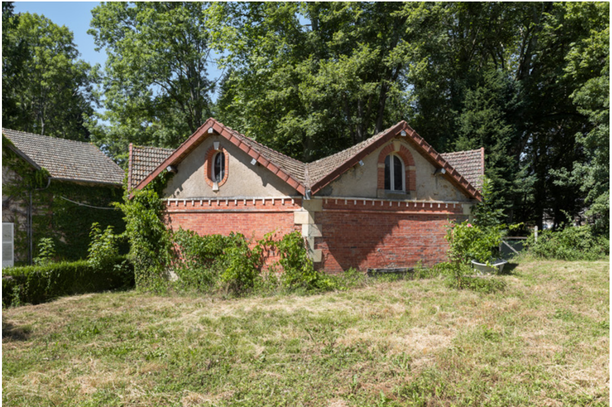
Vue depuis le sud-sud-est.
