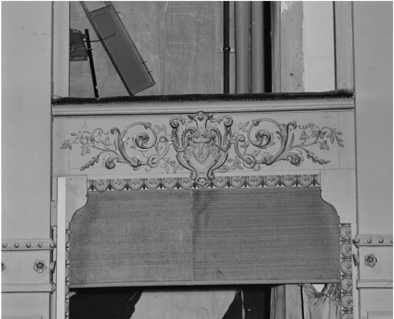
Salle : détail du garde-corps de la 2e loge d'avant-scène, côté jardin, en 1988, avant restauration.
