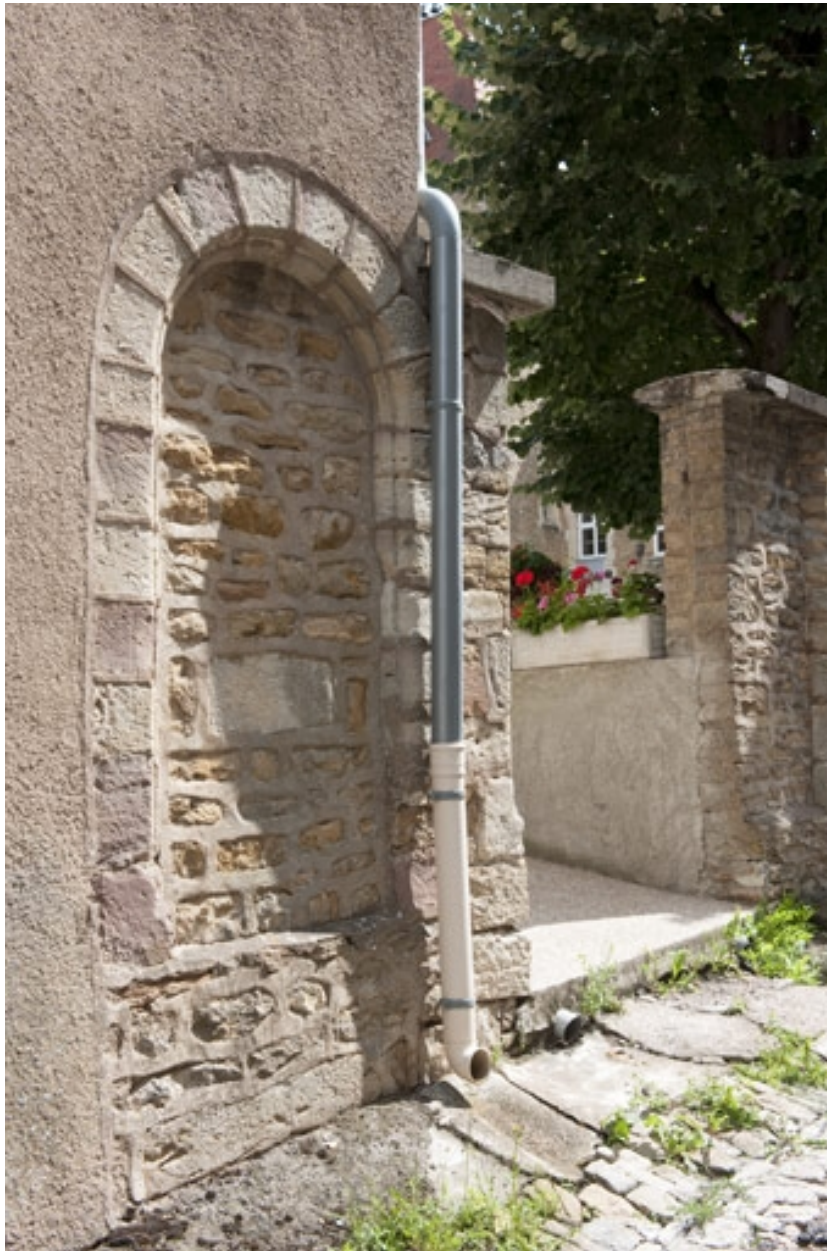
Bâtiment (B), ancienne porte.
