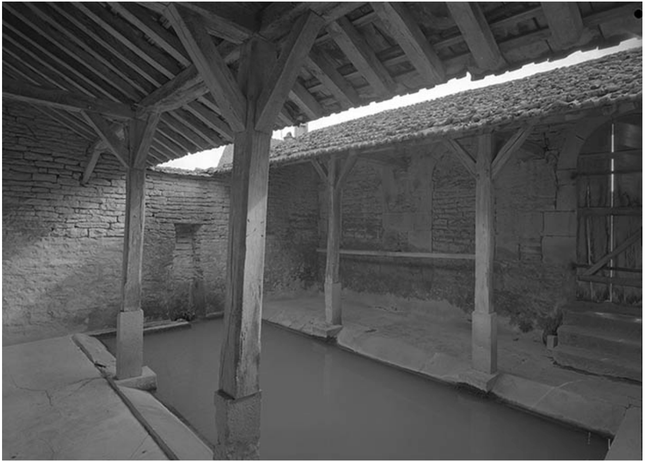
Vue intérieure. Bassin et charpente.
