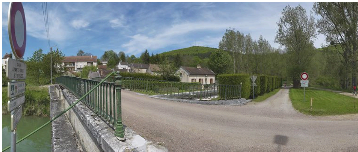
Pont vu d'aval.
