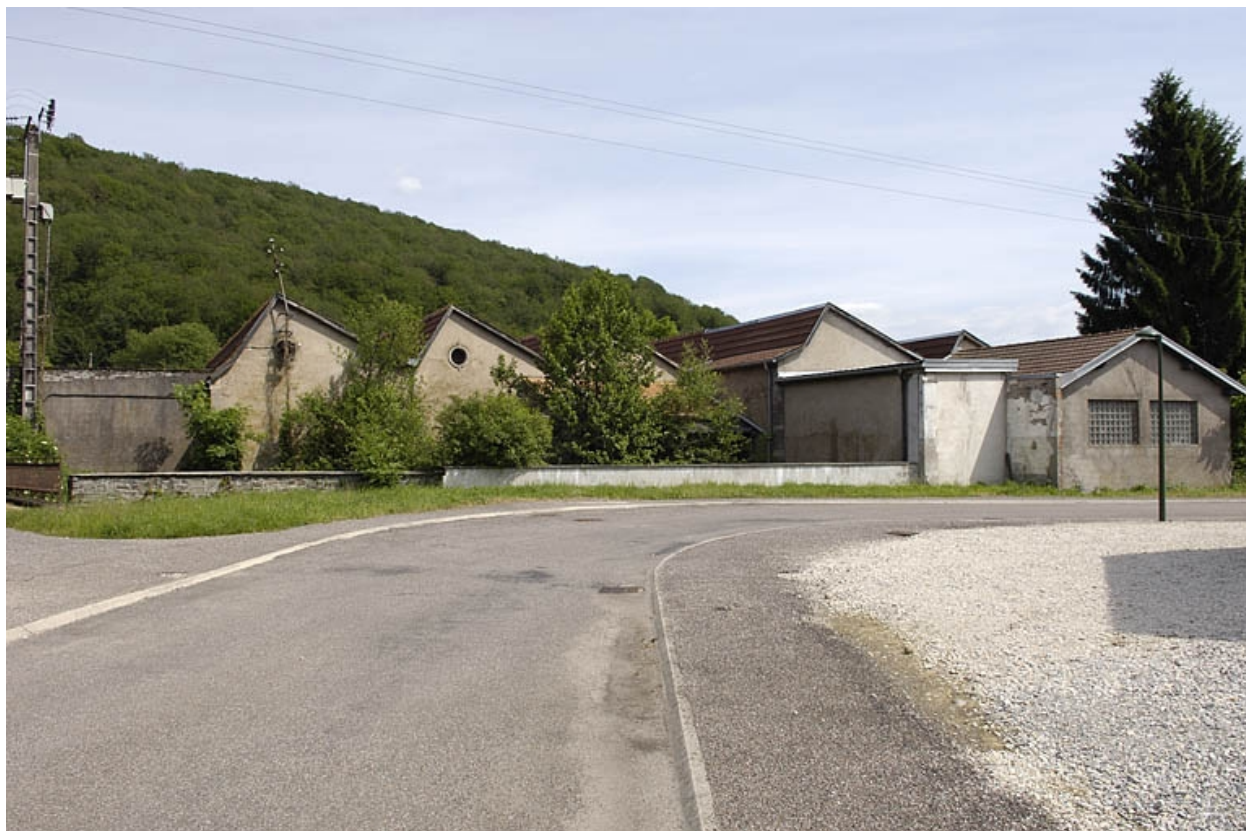
Atelier de fabrication vu depuis l'ouest.
